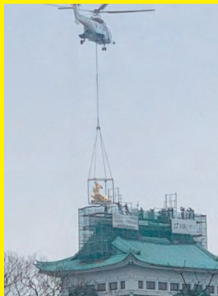
ヘリコプターによる吊上げ
