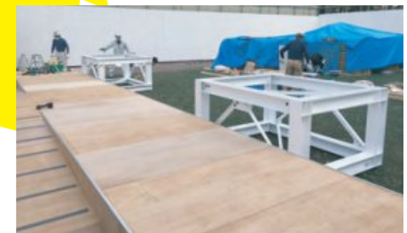
ステージと金シャチ台座鉄骨組
