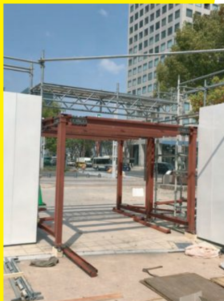
エントランス鉄骨組
